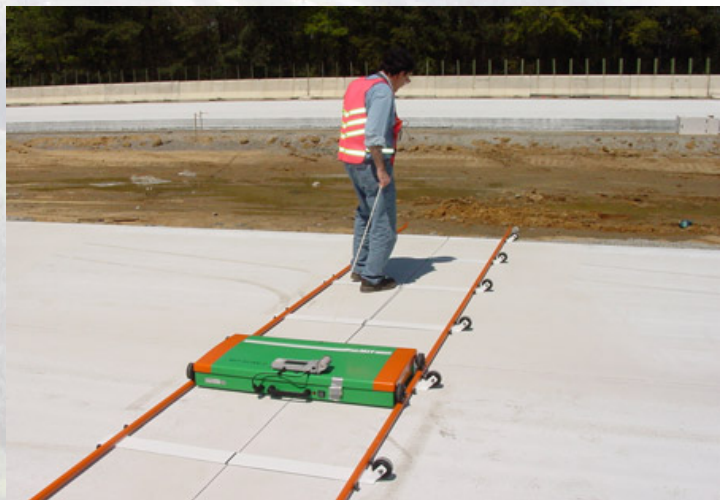
Locating dowel bars using the MIT Scan-2
